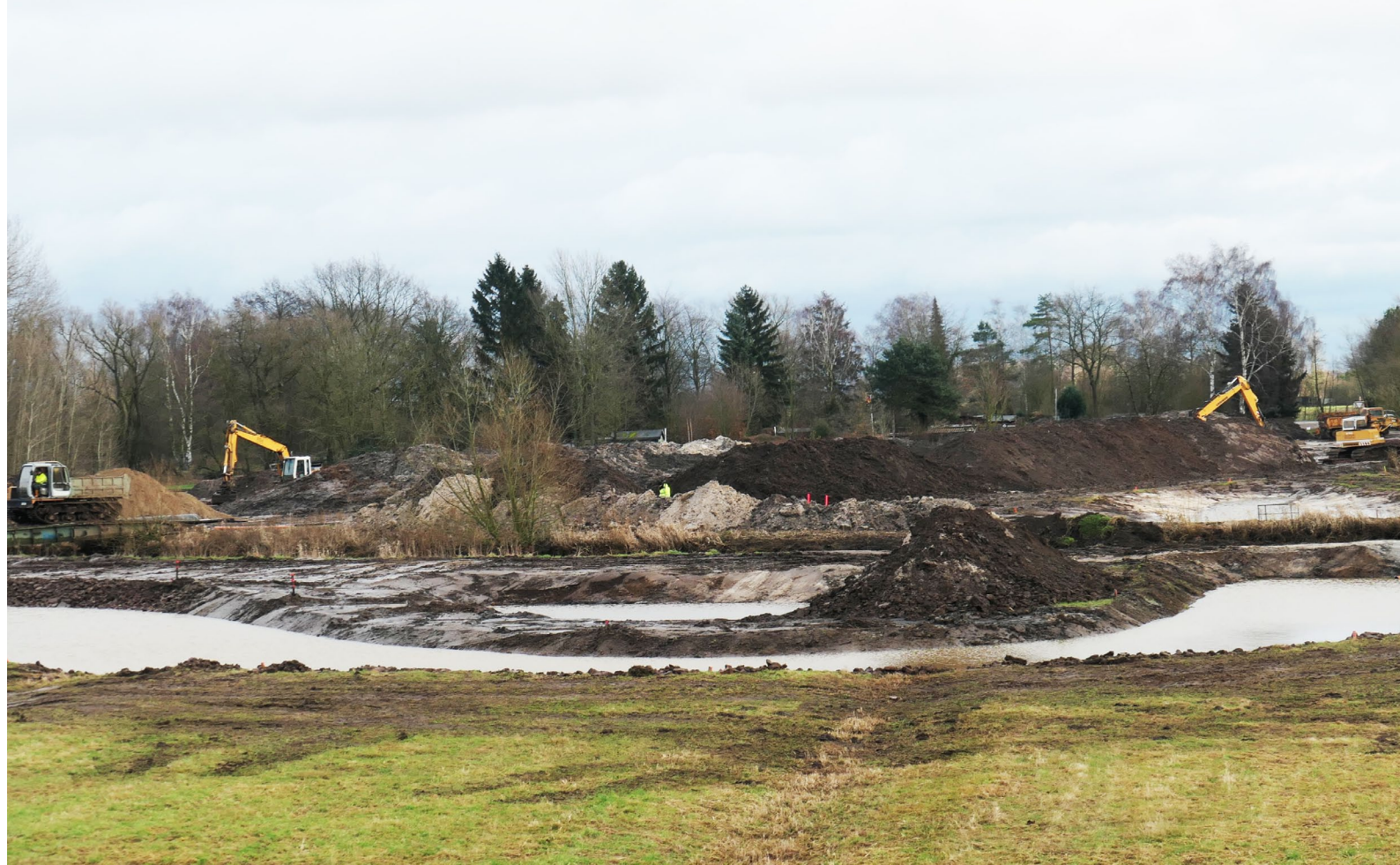
Ein Beispiel für eine Laufverlegungsmaßnahme - hier an der Luhe.
